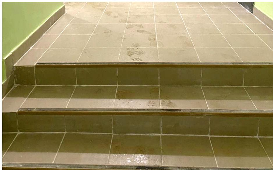
Противоскользящий угол-накладка монтируется на плитку на каждой ступени для безопасности передвижения в подъезде
