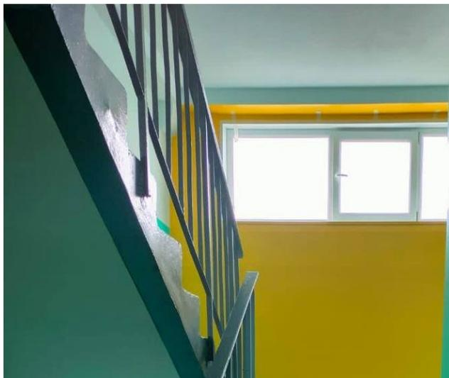
Прокрашивание окантовки нижней поверхности лестничного марша защищает побелочный слой от разрушения подтёками при влажной уборке
